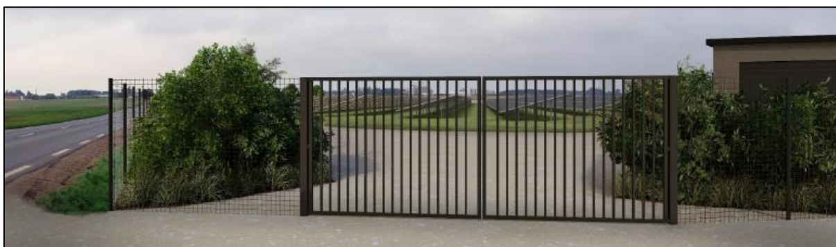
Vue projetée depuis le chemin rural existant par lequel va s'effectuer l'accès à la centrale solaire (Source : IEA)
