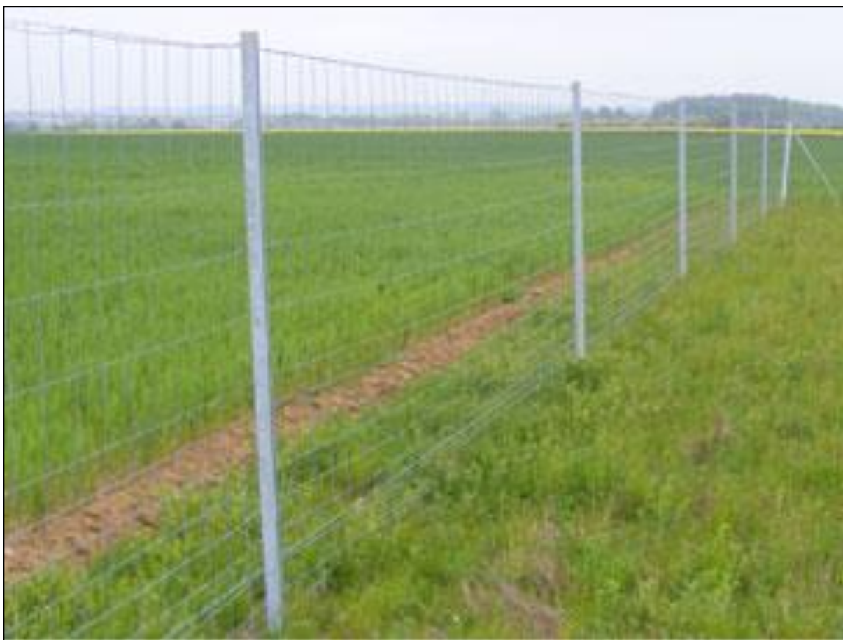
Exemple d'une clôture (Source : TotalEnergies)
