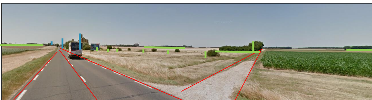
Vue depuis la RD 357 en direction du secteur d'étude
