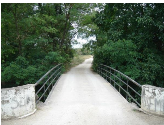
Pont de Baulette
